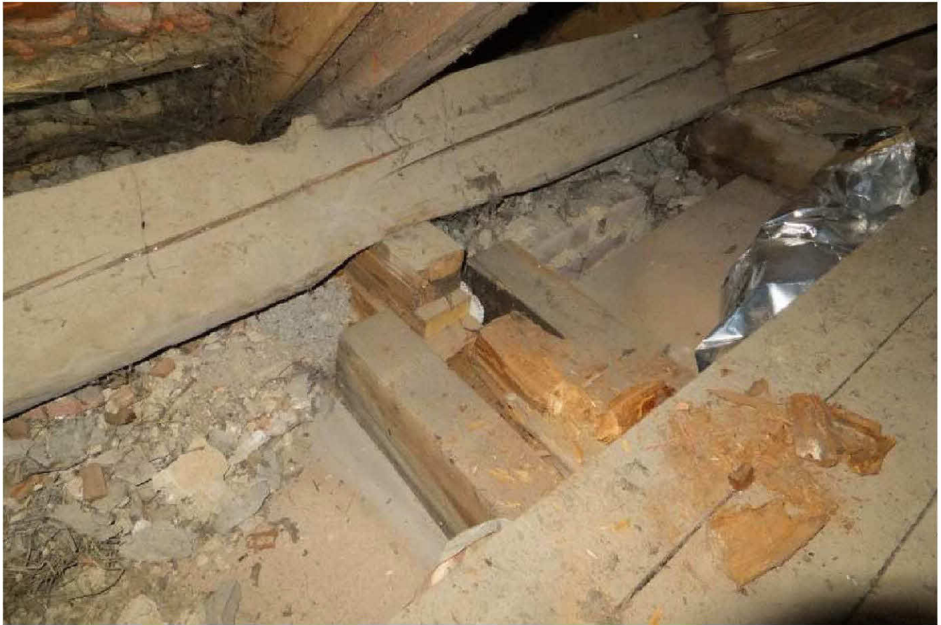
Kirchenschiff: Anlaschung morscher Zerrbalken, Ersatz Mauerlatte
