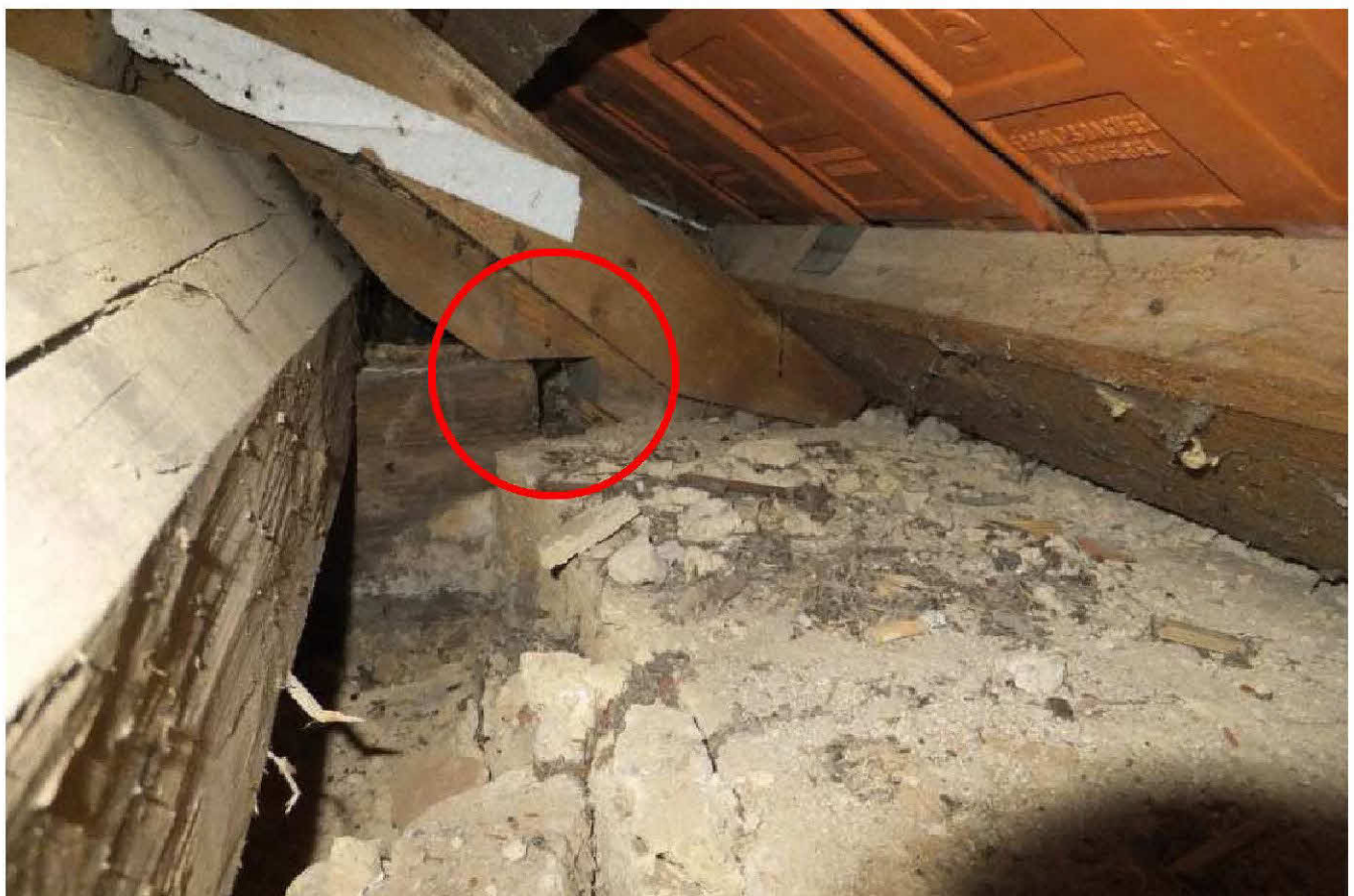
Kirchenschiff: Sparrenfußpunkt verschoben
