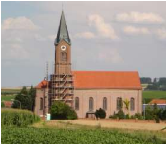
Erste Gerüstarbeiten am Turm werden ausgeführt.
